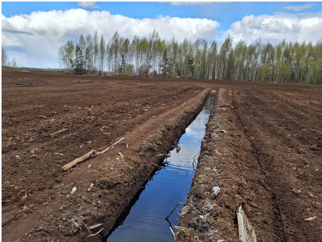
2.7 pav. Durpių gavybos laukuose iškasti sausinamieji bareliniai grioveliai.
