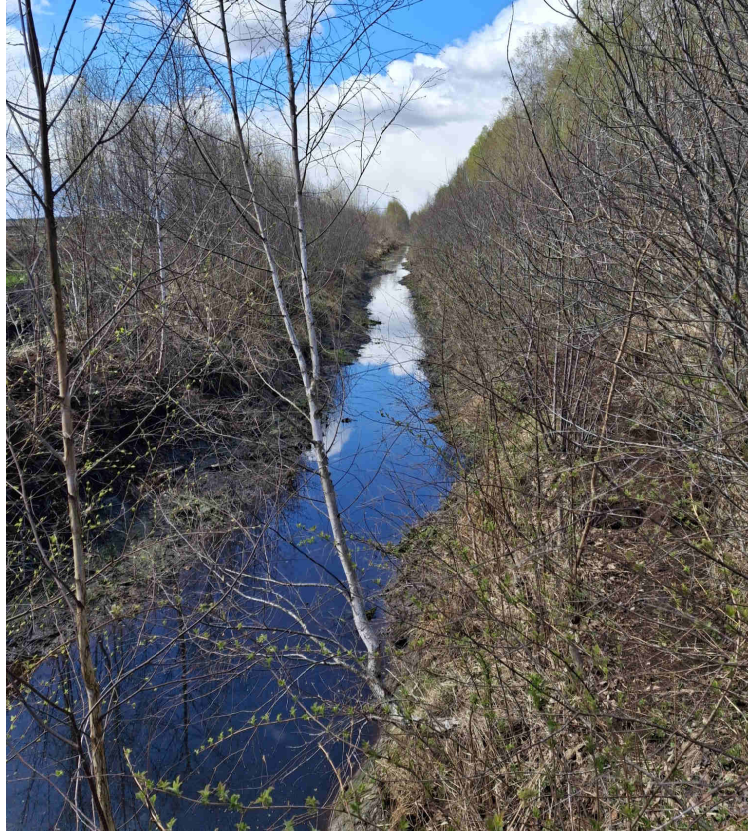
2.6 pav. Aplink eksploatuojamą durpyną iškastas apjuosiantysis sausinamasis griovys (nuotrauka daryta ties šiaurės rytiniu eksploatuojamo durpyno pakraščiu).
